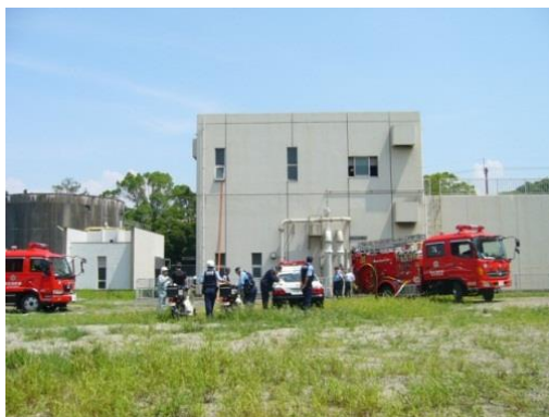
事故発生時の状況（高石送泥ポンプ場全景）
