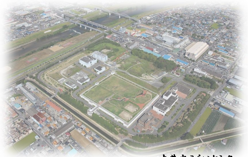
大井水みらいセンター
