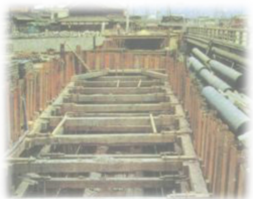
門真寝屋川幹線(二)古川横断箇所 (昭和41年度) (流域下水道40年の軌跡より)
