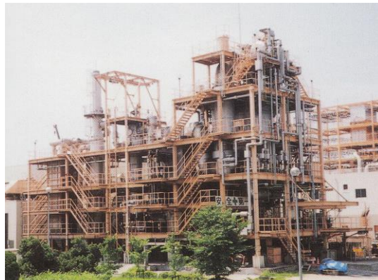
全国初の本格的溶融炉 中央処理場 70t/日炉 ※ 「流域下水道30年のあゆみ」より
