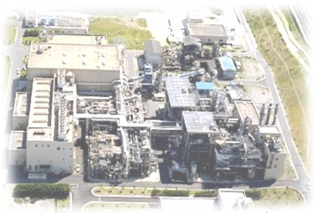
大阪南下水汚泥広域処理場 (流域下水道40年の軌跡より)
