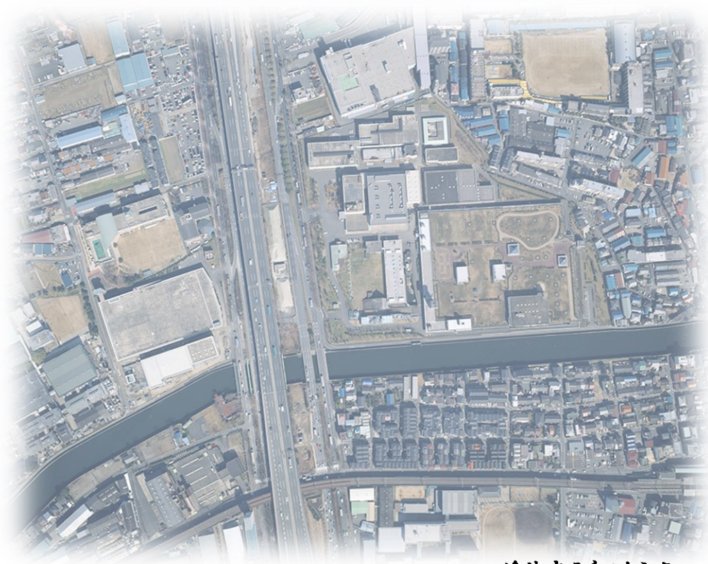
鴻池水みらいセンター
