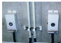
写真4 ガス測定装置(槽内測定用)
