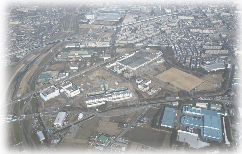
高槻水みらいセンター
