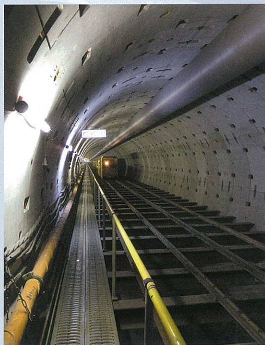
現在も工事の進む 「寝屋川流域下水道飛行場北増補幹線」
