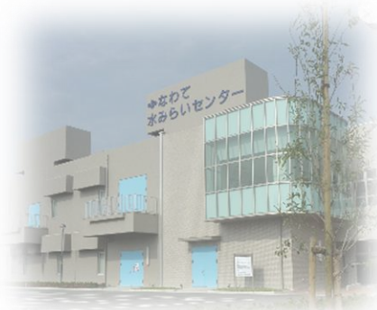
なわて水みらいセンター(管理棟)
