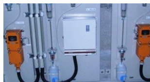
写真3 ガス測定装置(室内測定用)
